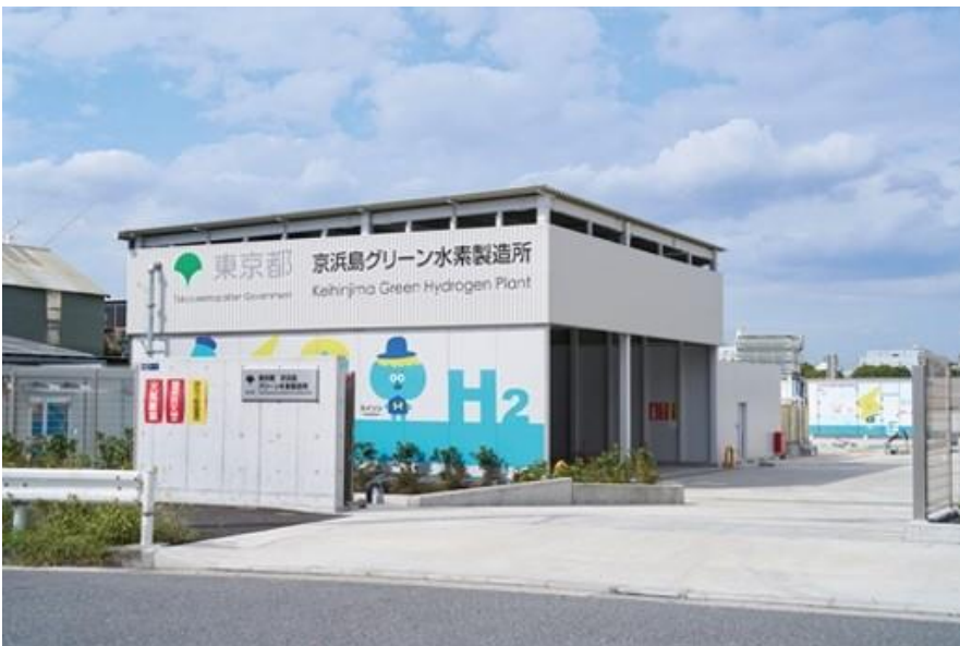
京浜島グリーン水素製造所
