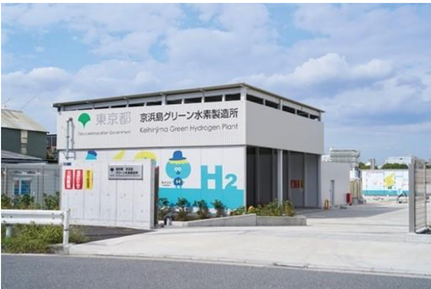
京浜島グリーン水素製造所
