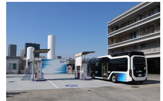
水素ステーション
