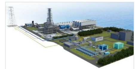
水素製造・貯蔵・発電実証設備イメージ図 ©三菱重工業 (株)
