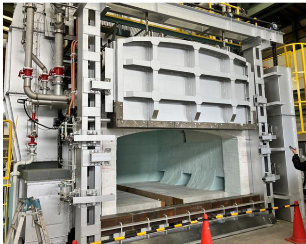
図: 新設した加熱炉
