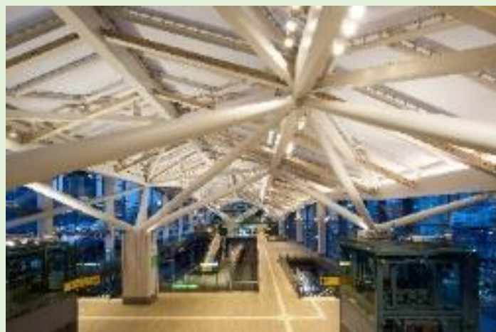
膜屋根採用による 照明電力量削減
