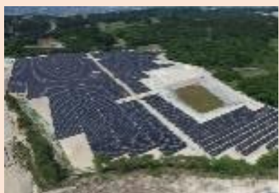
宮城県大崎三本木 太陽光発電所
