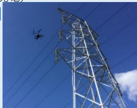
ドローンを活用した送電線検査
