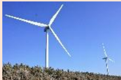
秋田県三種 風力発電所
