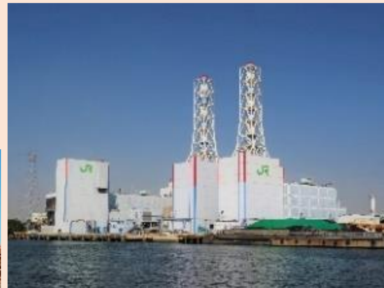
川崎火力発電所
